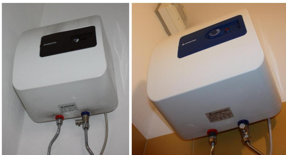
*Figura 12 . Boiler per a.c.s.*
