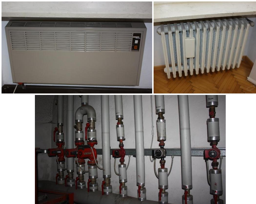
*Figura 11 . Alcuni corpi scaldanti e le pompe di circolazione.*
